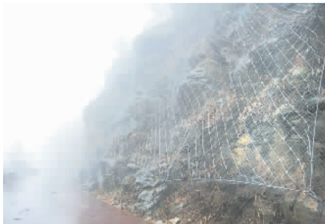
荆历线上挂网防滑坡
