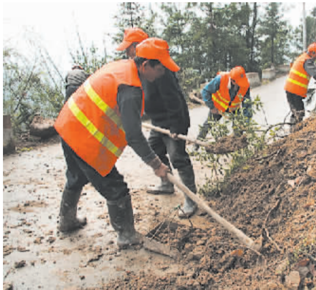
道路抢险队清理山体滑坡
